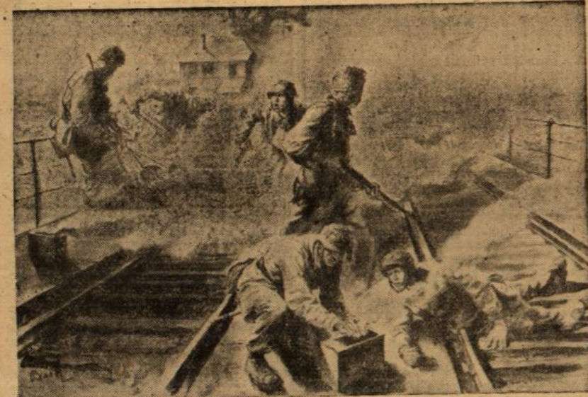
Auf alle Möglichkeiten vorbereitet! — Ein Trupp Fallschirmjäger stürzt zur nahegelegenen Eisenbahnbrücke. Unter allen Umständen muß eine Sprengung durch den Feind verhindert werden. Um sie jeder Feindeinsicht zu entziehen, wird sie vernebelt. PK-Zeichnung: Baltz (Graphis)
