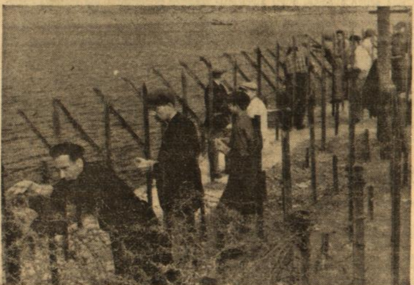
Ausbau der adriatischen Küstenbefestigungen. — Italienische Arbeiter, die nach deutschen Grundsätzen entlohnt und verpflegt werden, helfen der deutschen Wehrmacht beim Ausbau der Küstenbefestigungen in einem Hafen an der Adria.
