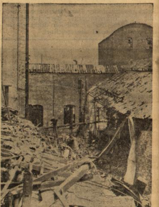
Wo man in den Tagen nach der Sprengung der Ersteiner Zuckerfabrik hinkam, überall bot sich dasselbe Bild: Restlose Zertrümmerung, das war die Absicht. Keine Fensterscheibe ist mehr ganz geblieben. Die Dächer sind abgedeckt oder restlos in sich zusammengefallen. Die deutschen Truppen fanden nur noch ein wüstes Durcheinander vor.
