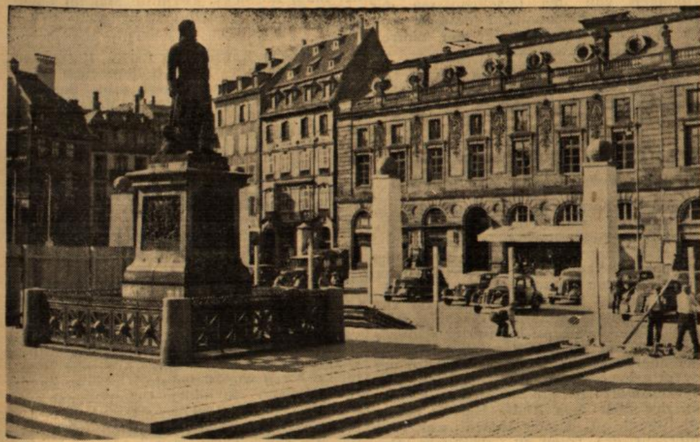
Zur Zeit errichten Zimmerleute um das Kleberdenkmal auf dem Karl-Roos-Platz einen hohen Bretterzaun.
