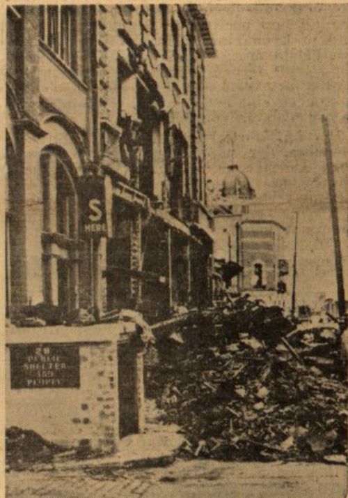
Zerstörte Lagerhäuser in einem englischen Hafen sprechen eine beredte Sprache. Aufnahmen: Weltbild
