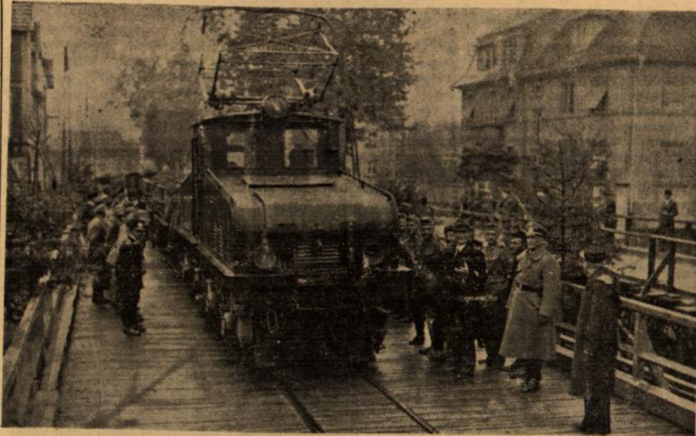
Der Lastzug der Strassenbahn nimmt auf der Breuschbrücke die Belastungsprobe vor.
