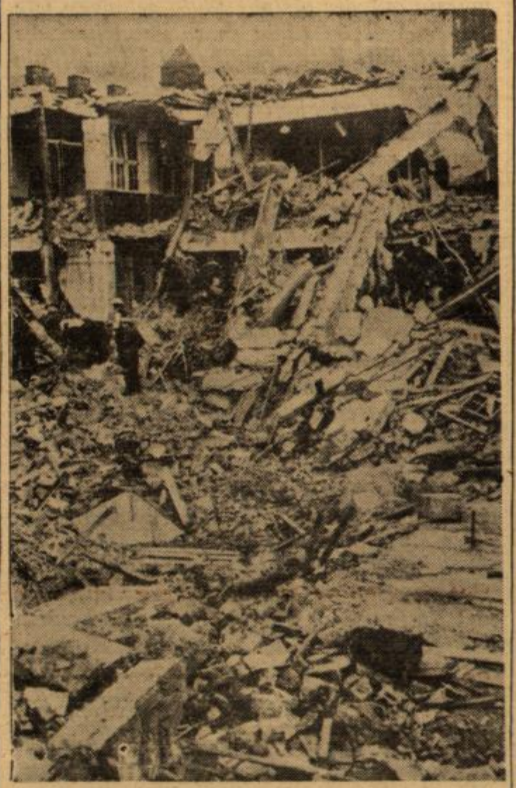
Vergeltungswirkung in London: Zerstörte Lagerhäuser (Aufnahme Weltbild)
