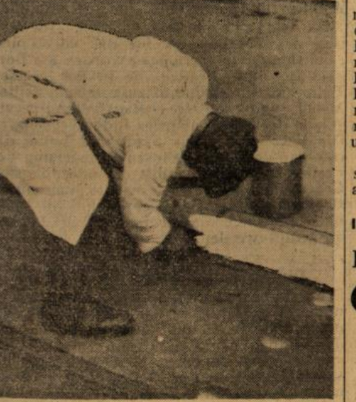
Sorgfältig streicht der Maler die Bordsteine an Strassenkreuzungen und wichtigen Übergängen mit weisser Farbe an. Sie soll uns helfen, bei Nacht leichter über die Strasse zu kommen, eine Massnahme, die sich in allen Städten des Reiches bestens bewährt hat. (Aufnahme Amann)
