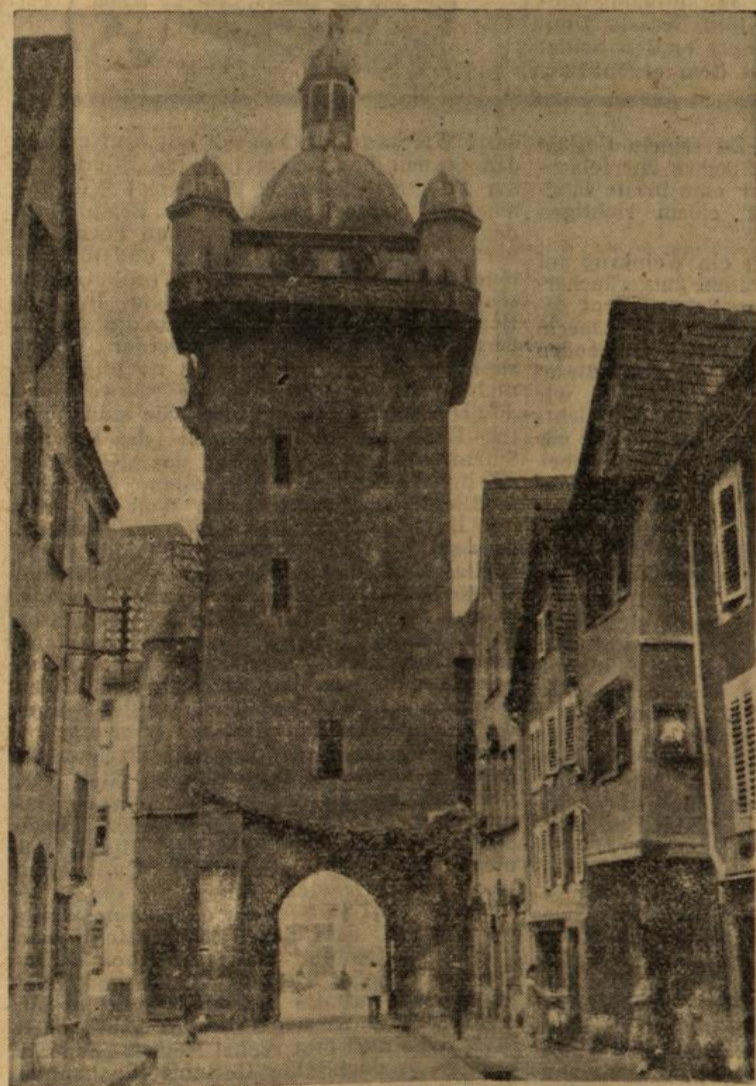
Blick auf den neuen Turm und die Rittergasse des alten Städtchens
