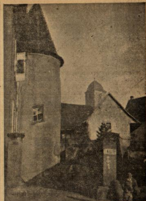
Ein schöner alter Treppenturm
