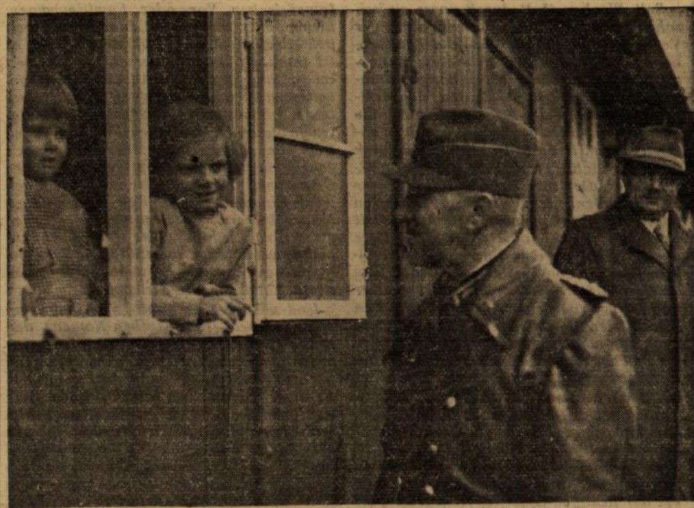
Am Montag besuchte der Reichsarbeitsführer, Reichsleiter Hierl, auf seiner Besichtigungsfahrt nach den Einsatzstellen des Reichsarbeitsdienstes im besetzten Gebiet, auch Strassburg. Unser Bild zeigt den Reichsarbeitsführer bei einem Besuch in der vom RAD errichteten Siedlung nahe bei dem zerstörten Markolsheim. (Bericht siehe auf Seite 5.) Aufnahme: Amann
