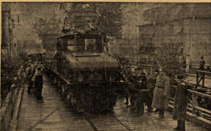
Der Lastzug der Strassenbahn nimmt auf der Breuschbrücke die Belastungsprobe vor.
