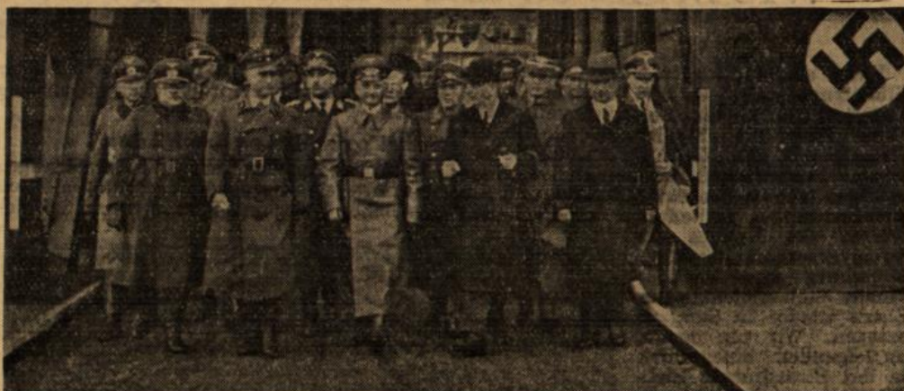
Die neue feste Brücke über den Rhein zwischen Strassburg und Kehl ist fertiggestellt und dem Verkehr übergeben. Reichsstatthalter Robert Wagner mit seiner Begleitung bei der ersten Begehung der schönen, neuen Holzbrücke, die, eine völlig neuartige Konstruktion, eine hervorragende deutsche Ingenieurleistung darstellt. (Ausführl. Bericht s. S. 1) Aufnahme: Amann
