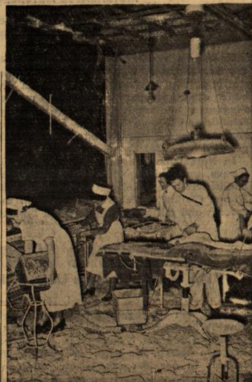
In der Nacht zum Dienstag unternahmen die englischen Luftpiraten einen Angriff auf die Reichshauptstadt, wobei sie Brand- und Sprengbomben auf Wohnhäuser und mehrere Krankenhäuser abwarfen. Unser Bild zeigt den zerstörten Operationssaal des Robert Koch-Krankenhauses (Weltbild)
