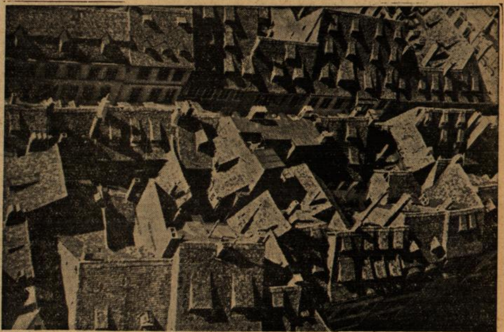
Wie aus der Spielzeugschachtel, so sieht das Dächergewirr der Strassburger Altstadt aus, von der Höhe des Münsters betrachtet. Aufnahme: M. Lederer.
