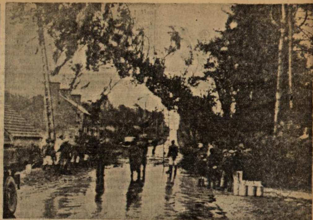
Sturmschäden an der Kanalküste! Unsere Soldaten springen helfend ein.
