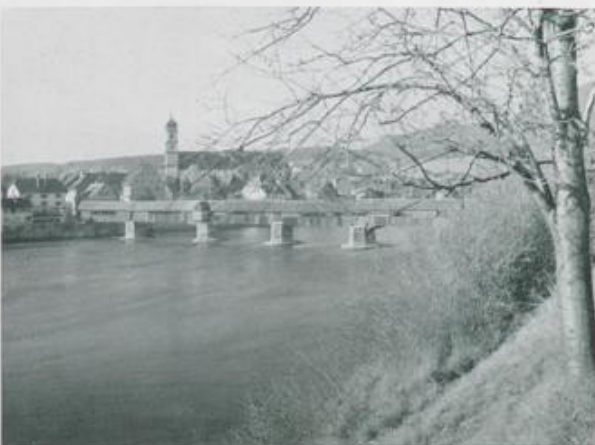
Säckingen (Überdachte Holzbrücke)
