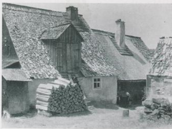
Schindelgedecktes Bauernhaus aus dem Renchtal
