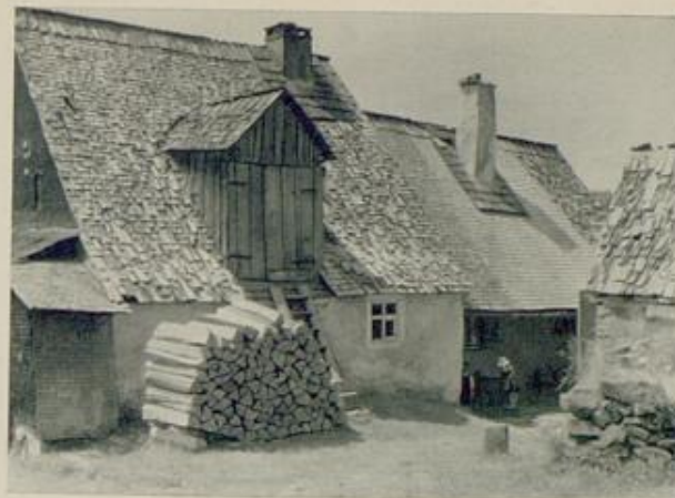
Schindelgedecktes Bauernhaus aus dem Renchtal
