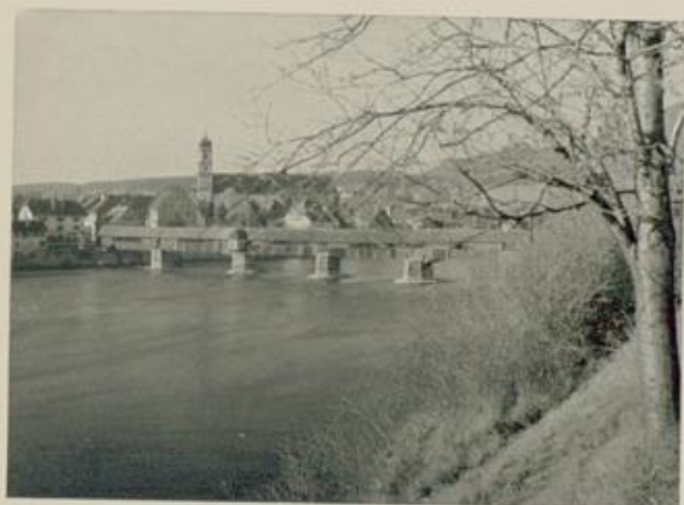
Säckingen (Überdachte Holzbrücke)
