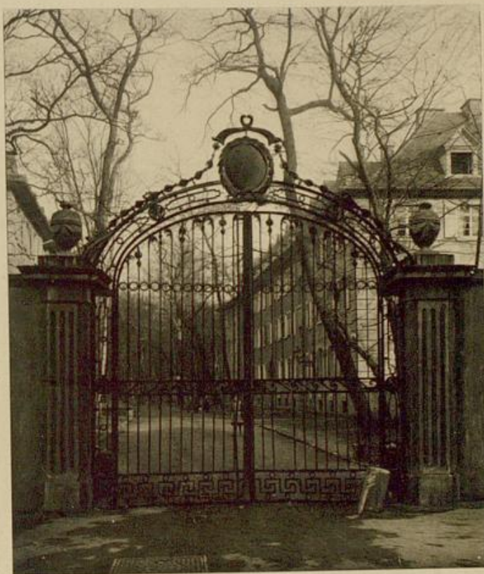
Abb. 6. Gittertor am Eingang zum Fasanengarten im Zirkel. Hinter dem Tor die vom Verfasser in den Jahren 1921/1923 erbauten Beamtenwohnungen.
