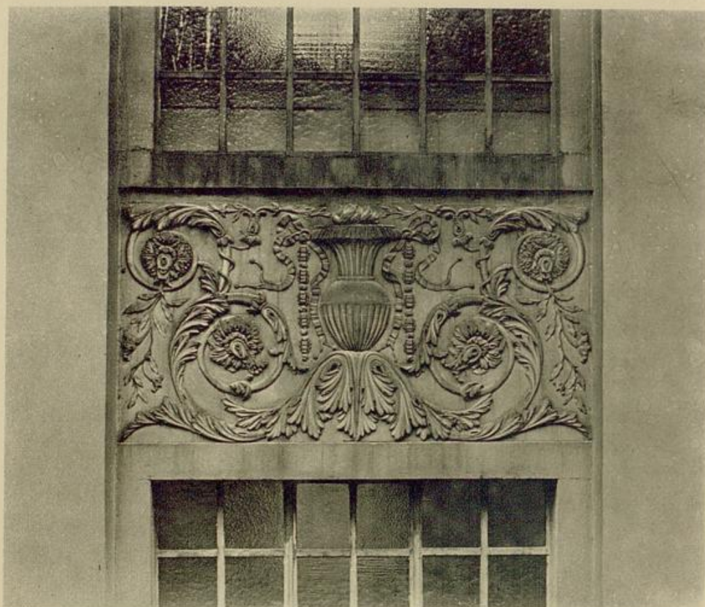
Abb. 28. Fensterbrüstung am Außen der ev. Stadtkirche zu Karlsruhe.
