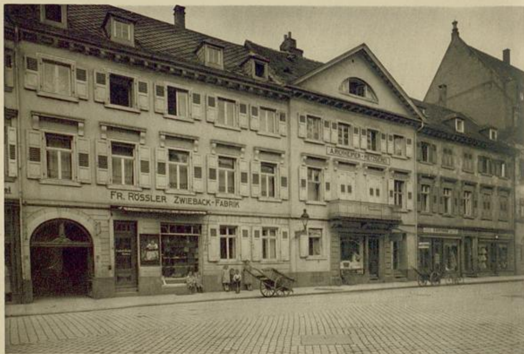
Abb. 50. Die Häuser Nr. 32, 34 und 36 an der Nordseite der Markgrafenstraße.
