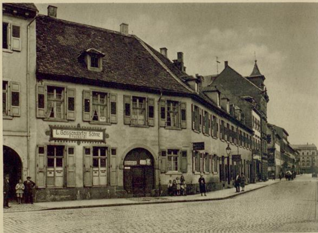
Abb. 51. Das Haus Steinstraße Nr. 31 mit der gebrochenen Ecke hat Schreinermeister Wagner im Jahre 1806 gebaut. Die daran anschließenden Häuser Markgrafenstraße Nr. 31 (1810), Nr. 33 und 35 (1812) hat Künzle erstellt. Das Haus Steinstraße Nr. 29 auf dem Bild nur noch in einer halben Achse sichtbar, hat im Jahre 1810 Künzle für den Käufer Jakob Kies gebaut.
