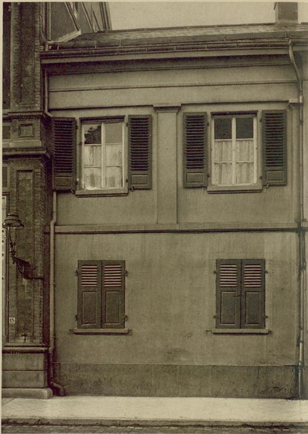
Abb. 89: Das heutige Staatsministerium, Erbprinzenstraße Nr. 15 Westlicher Verbindungsbau zwischen Corps de Logis und Flügelbau erb. 1804. Der östliche Verbindungsbau ist genau gleich.
