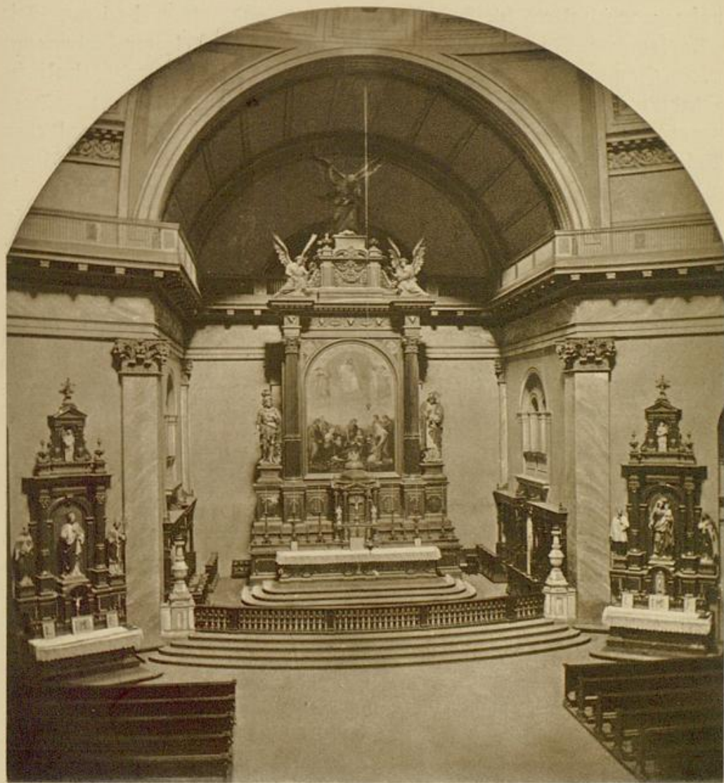
Abb. 156. Inneres der St. Stephanskirche nach der Renovation vom Jahre 1882.
