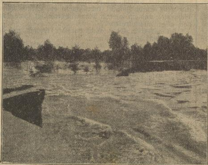
Das Hochwasser des Tessin flutet durch einen Dammbrech ins Land.
