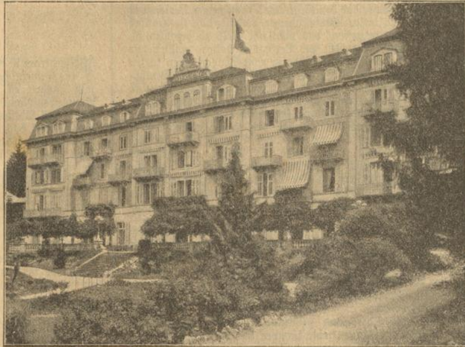
Hotel Arenstein am Vierwaldstättersee vor dem Brande.
