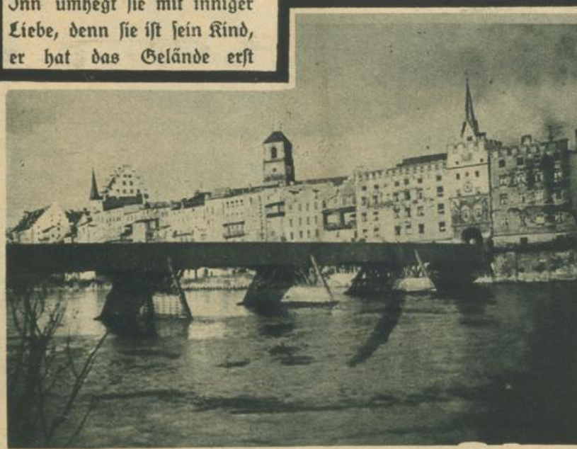
Alte Innbrücke bei Wasserburg
