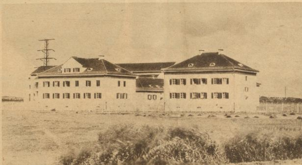
Hauptumspannwerk Karlsfeld bei München (Aussenansicht)
