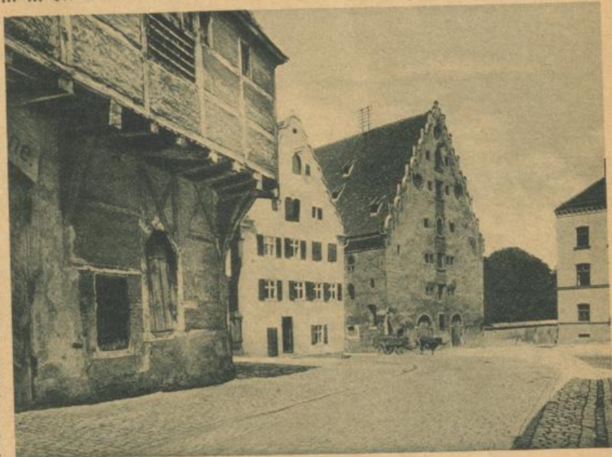
Ehemaliges Barfüßerkloster am „Hafenmarkt“
