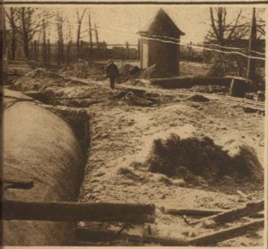
Am der Ausstellung in München. Fertig betonierter Tunnel der Liliputbahn Schröter, München
