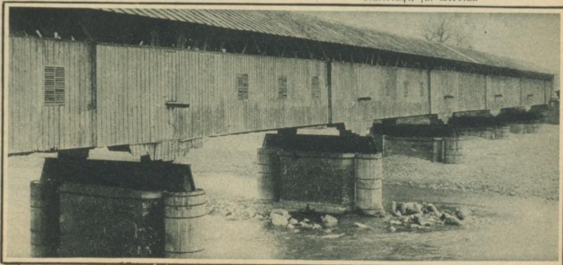
Sennecke Die älteste Eisenbahnbrücke der Schweiz (bei Ragaz) wird durch eine moderne ersetzt
