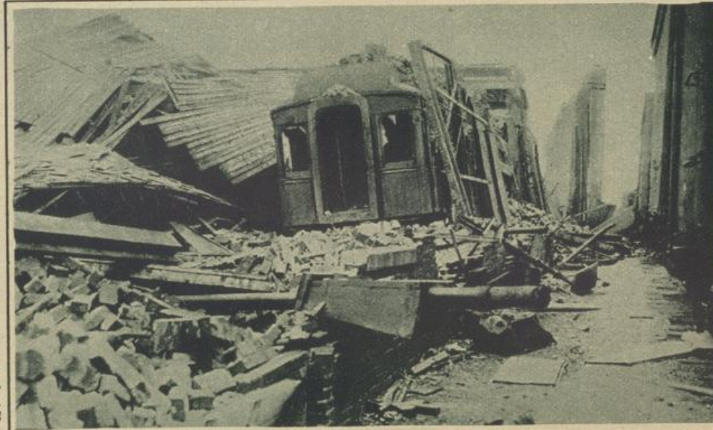
Die durch den Tornado total zerstörte Eisenbahnstation in Princetown Sennecke
