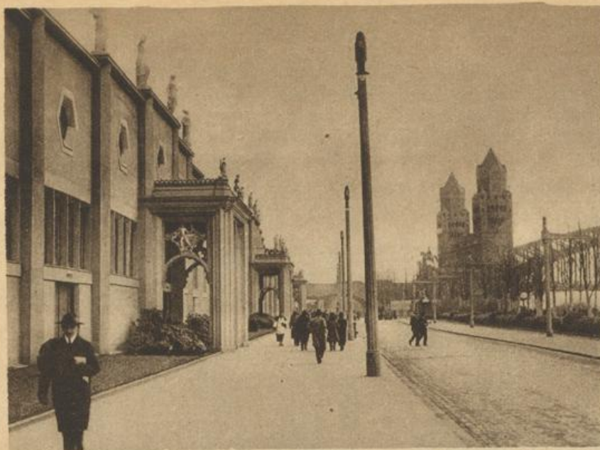
Blick auf Rheinseite und Rheinbrücke
