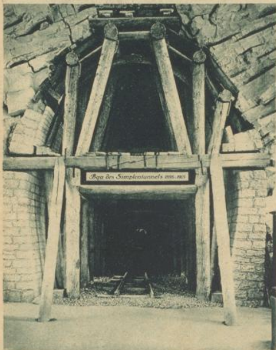
Getreue Nachbildung des Simplontunnels während des Baues
