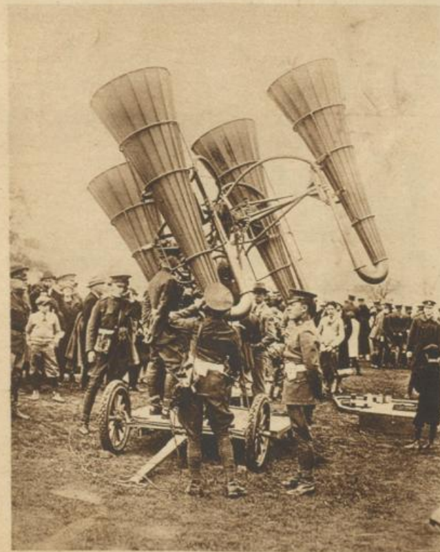
Schallempfänger mit denen amerikanisches Militär Entfernungen der Flugzeuge ermittelt Sennecke
