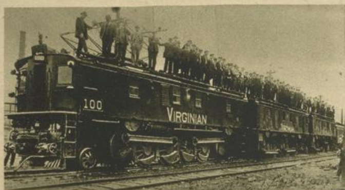
Die größte elektrische Lokomotive der Welt (Amerika) 152 Fuß lang; Gewicht 1,277,900 Pfd.
