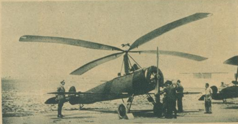
Ein neuer Flugzeugtyp „Autogiro“ wurde von dem spanischen Ing. Cacierva konstruiert — Das Flugzeug erhebt sich ohne Anlauf
