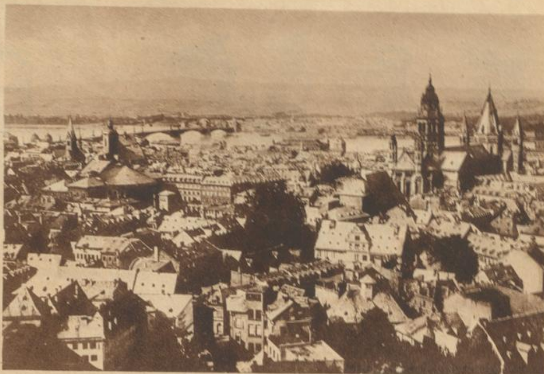
Gesamtansicht vom Stephansturm
