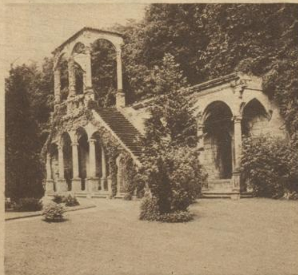
Das ehemalige Lustschloß in den Anlagen
