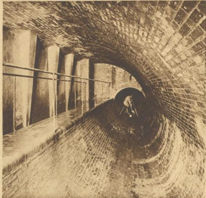
Die Abern der Großstadt — Regenwasserkanal
