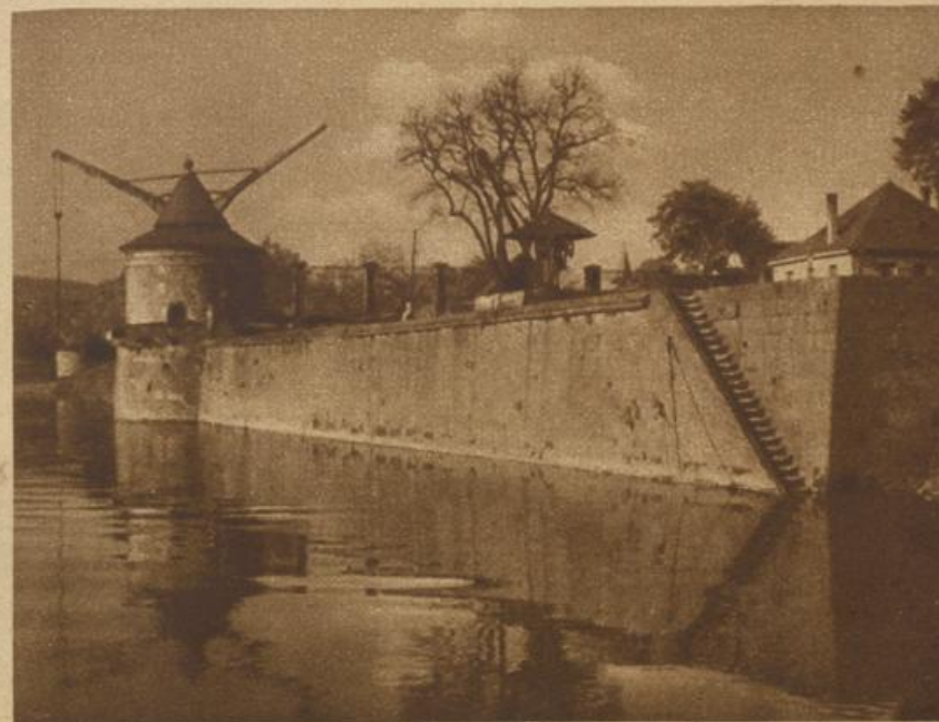
Am Kranen in Trier
