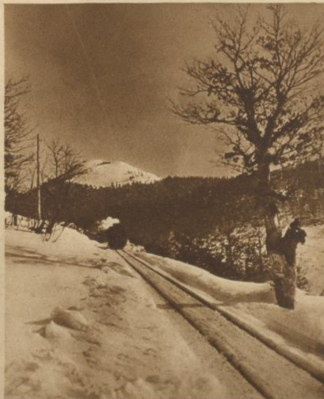
Die Steinbeis-Industriebahn im Schnee
