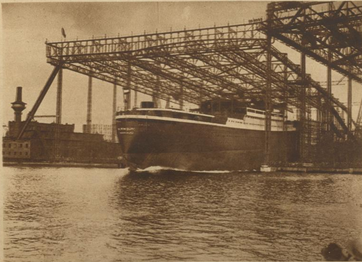
Stapellauf des Zweischrauben-Turbinendampfers „Hamburg“ der Hamburg-Amerika Linie! „Hamburg“ ist das 3. Zt. größte auf einer deutschen Werft in Bau befindliche Schiff. Es mißt 21 000 Br.R.T. und wird 1200 Passagiere befördern können. Im Mai nächsten Jahres soll der Dampfer seine erste Reise nach New York antreten.
