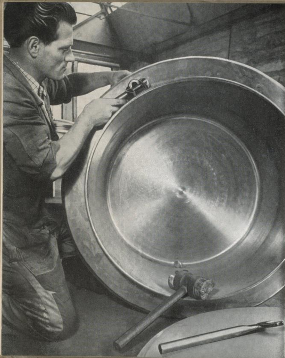
Montage eines Groß-Kochkessels
