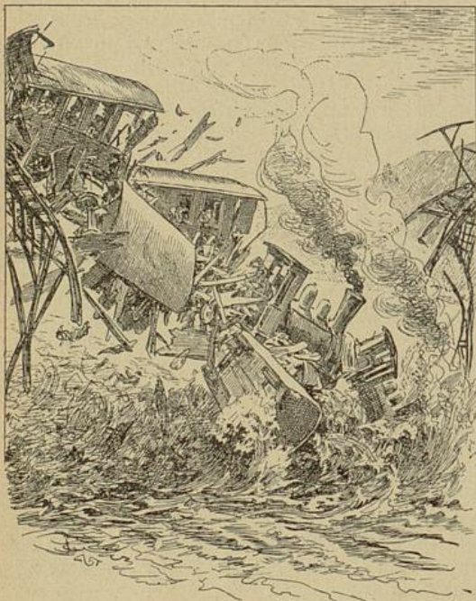
Die eiserne Brücke war unter der Last gebrochen.
