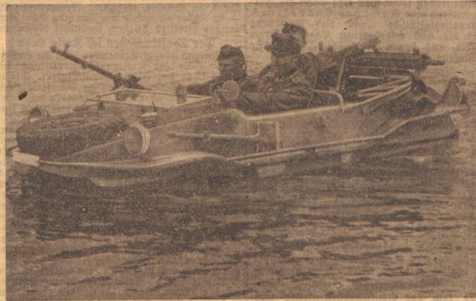
NSKK-Männer am Steuer des schwimmenden Volkswagens. An allen Fronten hat sich der Volkswagen selbst im schwierigsten Gelände hervorragend bewährt. Seine vielseitigen Einsatzmöglichkeiten haben durch die neueste Konstruktion als kombinierter Land- und Wasserfahrzeug eine weitere Ergänzung erfahren. — Unser Bild zeigt den Schwimmwagen in voller Fahrt/einen Fluß überquerend. NSKK-Kriegsberichtler Junk (Scherl)
