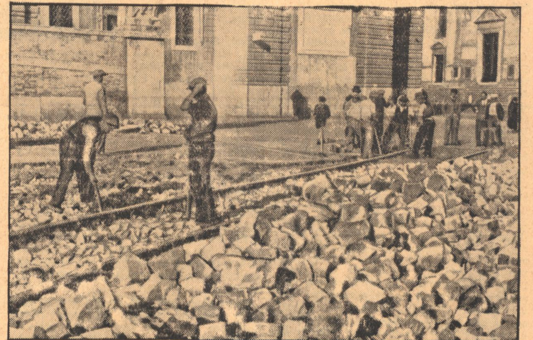
Schienen auf toten Strecken werden aufgerissen, um das Eisen ebenfalls für die Rüstungsindustrie nutzbar zu machen. (Webb, A.)
