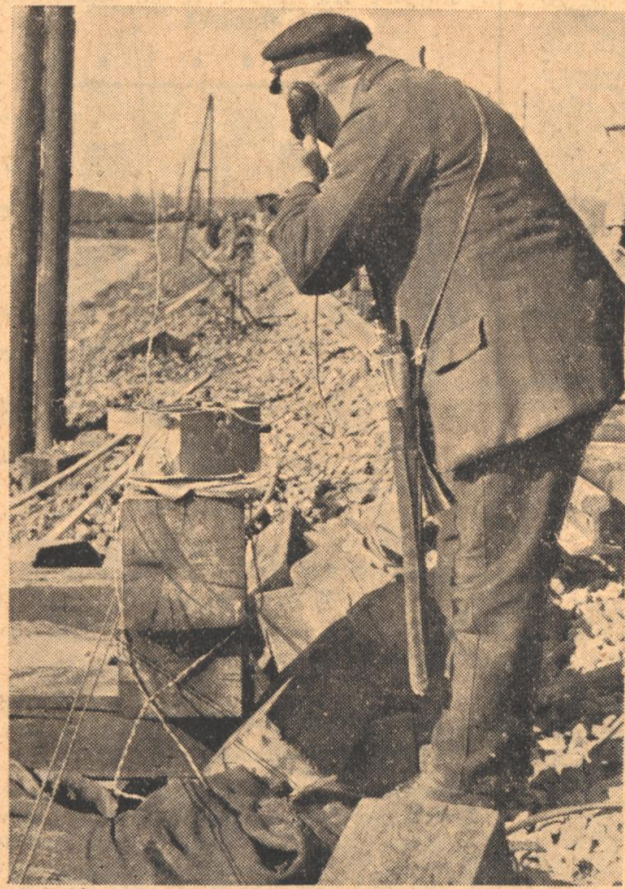
Hallo! Hier Baustelle Schienenstrang! Durch solche provisorischen Telefonleitungen ist die Baustelle zur Vermeidung irgendwelcher durch Fahrplanänderungen, Bauanweisungen und unvorhergesehene Fälle möglicher Gefahren verbunden
