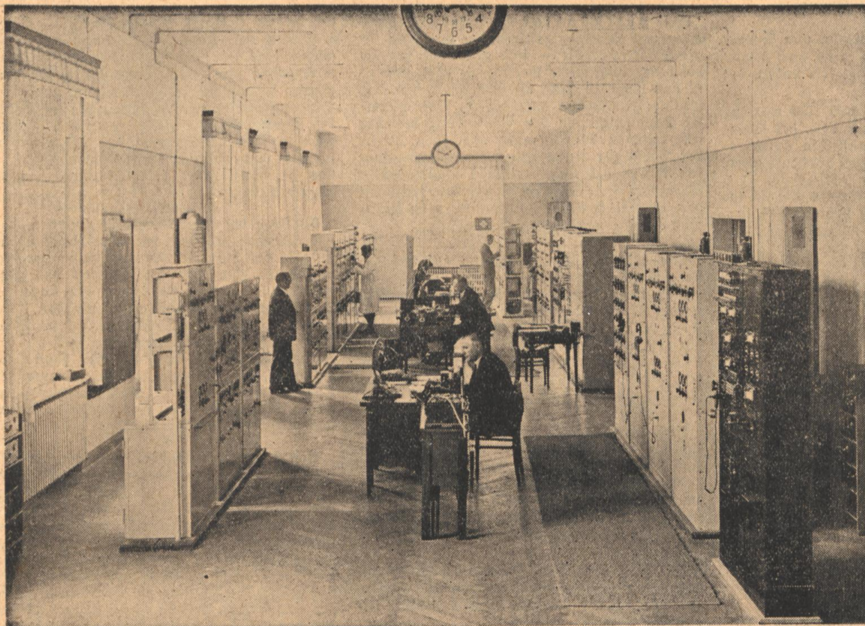
Blick in den Empfangsraum der Großstation Beelitz bei Berlin. Links und rechts stehen die Kurzwellenempfänger, mit denen die Sendungen von Uebersee aufgenommen werden. (Werkaufnahmen: Telefunken)
