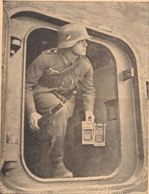
Ein Panzertor, eines Bunkers im Westwall, das im Ernstfall durch schwere Stahlplatten geschlossen werden kann
