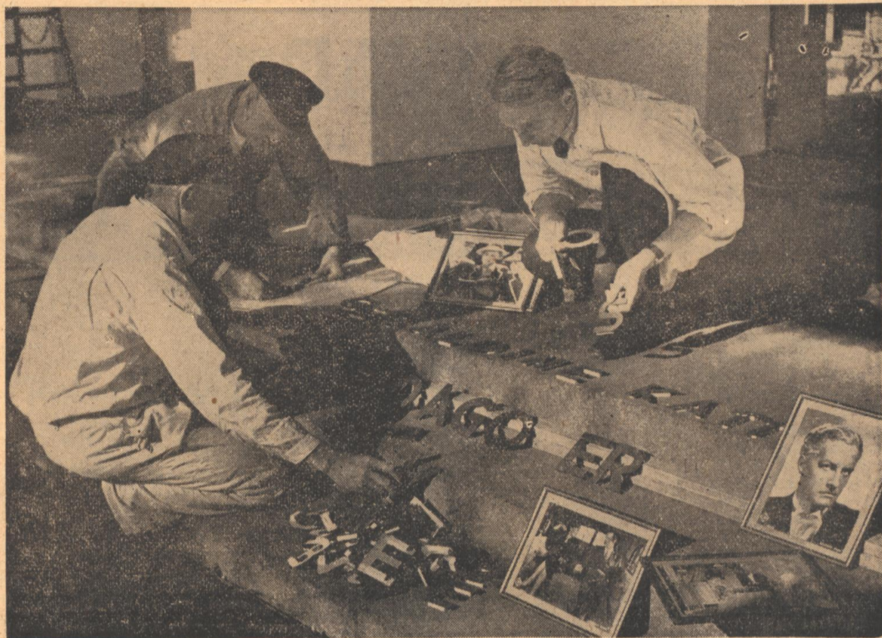
Am Morgen des Aufführungstages wird es vor dem Kinotheater lebendig — die Fassade wird für den neuen Film umgebaut. Unser Bild zeigt Arbeiter beim Zusammenstellen der Buchstaben, die neben den riesigen Frontbildern die Namen der in dem Film mitwirkenden Schauspieler nennen.
