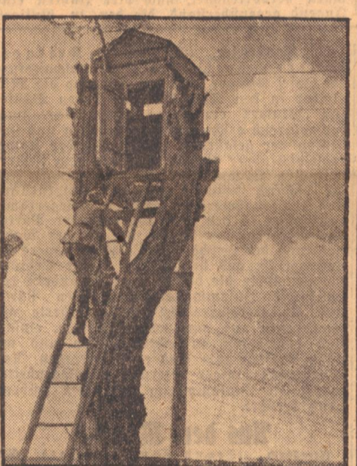
Deutsche Polizei sichert Eisenbahnstrecken im Osten. An den Bahnhöfen im Osten sind Polizeistützpunkte eingerichtet, die den Schutz der kilometerlangen Strecken gegen Sabotageakte übernehmen haben. — Der Beobachtungsturm eines Polizeistützpunktes an einer Bahnstrecke. (PK-Aufnahme: PK-Kriegsberichtler Seldel, Ordnungspolizei, Z.)
